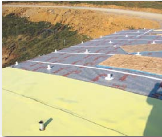
3 - Nem bariyeri ve kaplama malzemelerinin uygulanması
